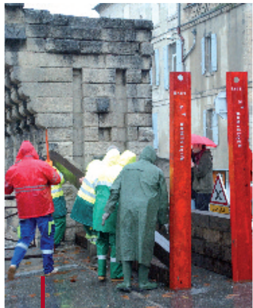
Test de mise en place de batardeaux
