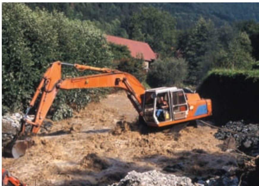
Crue de torrent - Sainte Agnès - curage du lit du torrent août 2005
