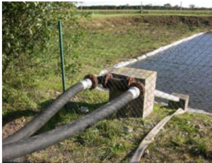
2 sorties de 100 mm sur une colonne de 150 mm
