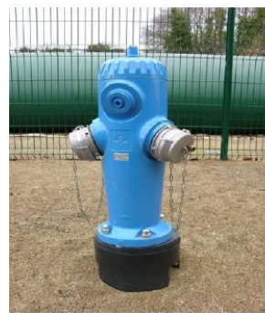
Poteau d'aspiration de 150 mm muni de 2 sorties de 100 mm et d'un carré de manœuvre
