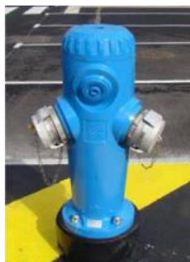
P.A.R.S. de 150 mm muni de deux sorties de 100 mm sans volant ni carré de manoeuvre.
