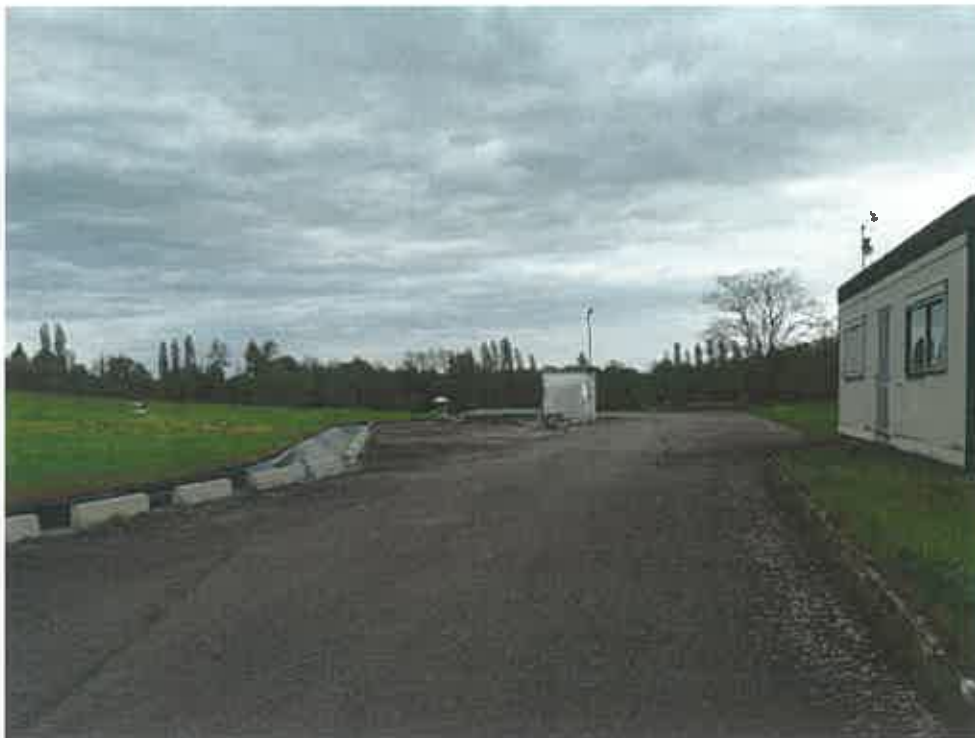
(2) – Voie bétonnée entre la DOM et la DDI
