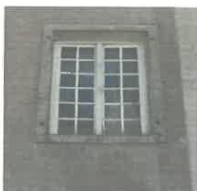
Fenêtre à petits carreaux, XVIII e siècle photo Archipat
