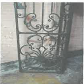
Portail intérieur en fer forgé, XVIII e siècle photo Archipat
