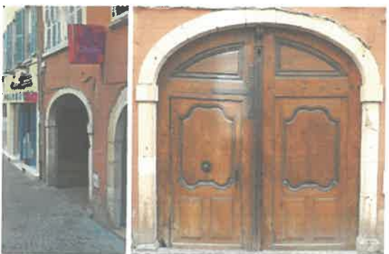
Imposte et vantaux de porte d'une maison, XVIII e siècle 21, rue Carnot (actuel n°51) - Inscription M.H. partielle du 15 janvier 1929
