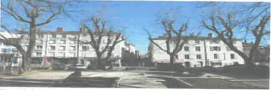
Place de la Barre Trame urbaine ancienne, intégrant des espaces de respiration : quais, places publiques, squares, présence végétale avec des jardins et parcs, etc.
