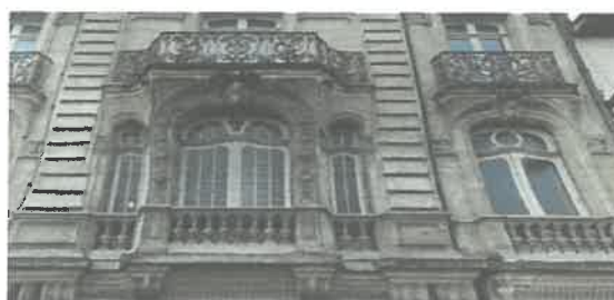
Portes-fenêtres à imposte vitrée, traverse en chapeau de gendarme, XIX e siècle photo Archipat
