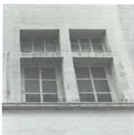
Baie à croisée avec menuiseries modernes, XVIII e -XIX e siècles photo Archipat
