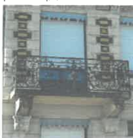
Garde-corps de balcon en fonte, XIX e siècle photo Archipat
