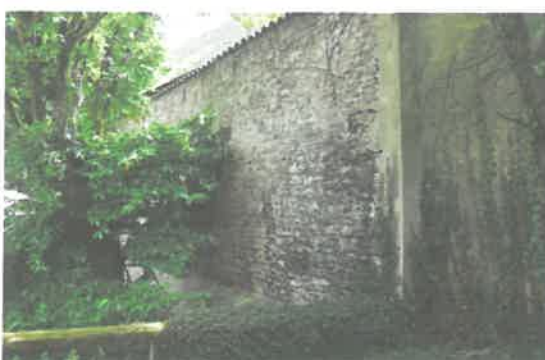
Probables vestiges du Castrum romain à proximité de la rue des Carmélites. photo Archipat
