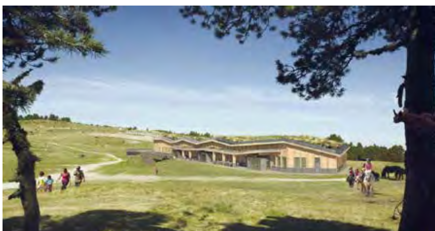
Projet de réhabilitation de l'espace nordique du plateau de Beille en Haute-Ariège financé par le Plan France Relance
