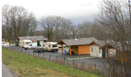
Terrain familial locatif , ici avec pièce de vie (Haute-Savoie)
