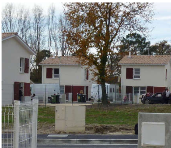
Exemple en Gironde (Blanquefort, source ADAV 33)
