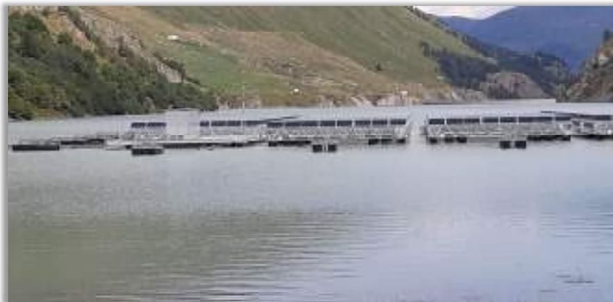
Figure 14 : Panneaux solaires sur flotteurs combinés (parc pilote sur un barrage hydroélectrique dans les Alpes suisses) – Source : Sciences Environnement
