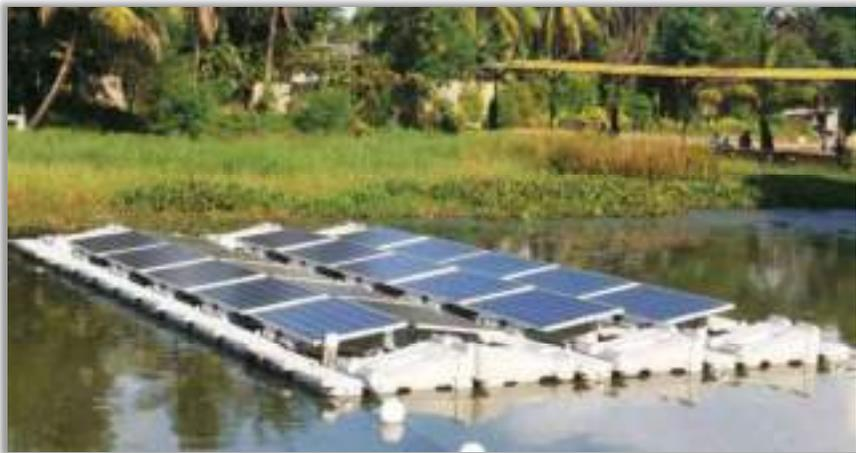
Figure 13 : Panneaux solaires sur flotteurs purs (Indonésie) - Source : Ciel & Terre international
