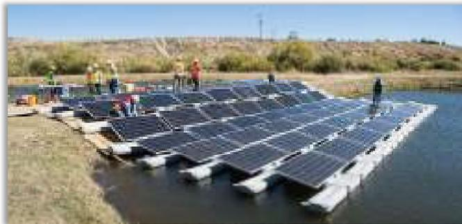
Figure 24 : Mise à l'eau à la main par des opérateurs à l'aide d'une rampe en bois (Source : Ciel & Terre)
