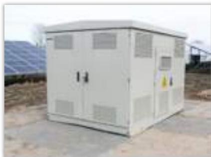
Figure 20 : Poste de transformation (Source : OX2)
