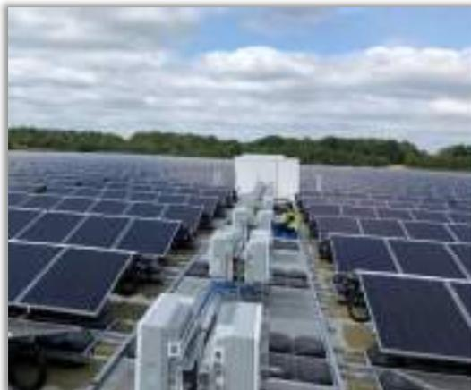
Figure 19 : Onduleurs décentralisés installés sur une allée de maintenance (Source : Zimmermann)
