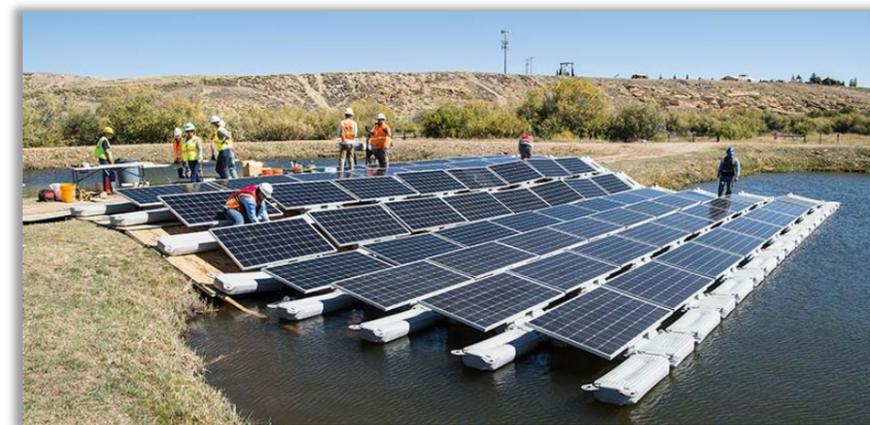
Figure 9 : Mise à l'eau à la main par des opérateurs à l'aide d'une rampe en bois (Source : Ciel & Terre)
