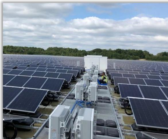
Figure 7 : : Onduleurs décentralisés installés sur une allée de maintenance (Source : Zimmermann)
