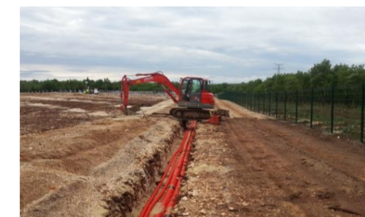
Exemple d'enfouissement de câbles électriques HTA
