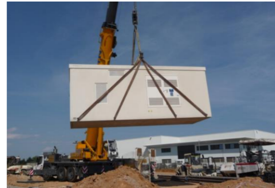
Exemple de déchargement d'un poste de livraison
