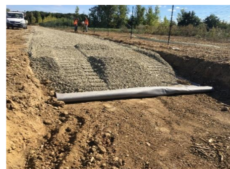
Exemple de réalisation de voie d'accès interne
