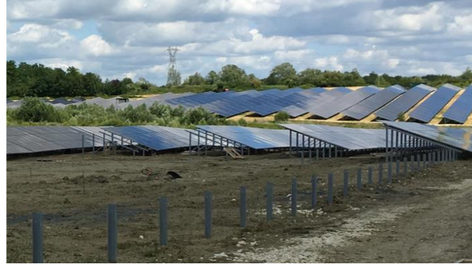
Exemple de centrale solaire mise en œuvre à l'aide de pieux battus
