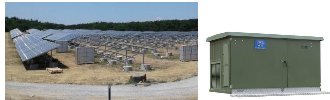
Photographie 1 – Exemple de fondation avec plot béton / pieux et poste de livraison (SMEG)
