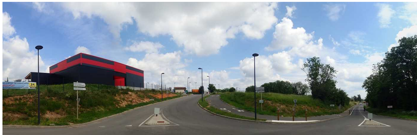
VUE 3 - Vue existante
