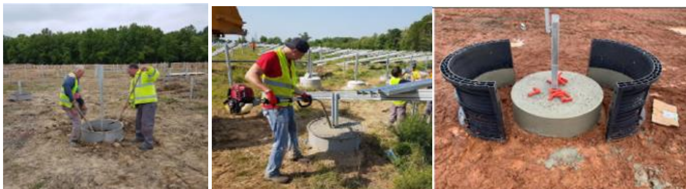
Photographie 2 – Etapes pour la réalisation des fondations « hybrides » : cerclage et pose du pieu au centre, coulage béton avec vibreur supprimant les bulles d'air, décoffrage
