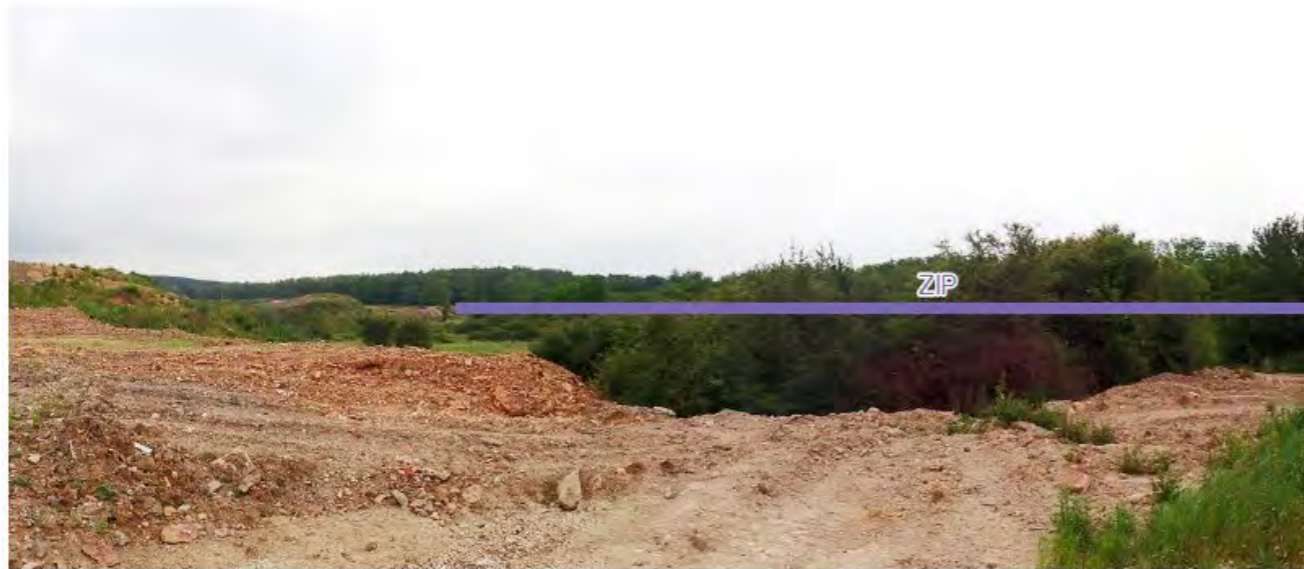
Photo 48 : Vue depuis l'ouest, vue sur la ZIP nord et centrale
