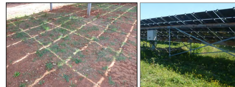
Photographie 25 - Aperçu de l'ombrage engendré par les panneaux d'une centrale photovoltaïque en recolonisation végétale spontanée : 1 an et 4 ans après travaux (ECO-STRATEGIE)
