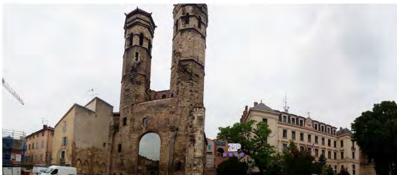
Photo 43 : Depuis les abords de l'ancienne cathédrale Saint-Vincent, la vue est fermée par le front bâti
