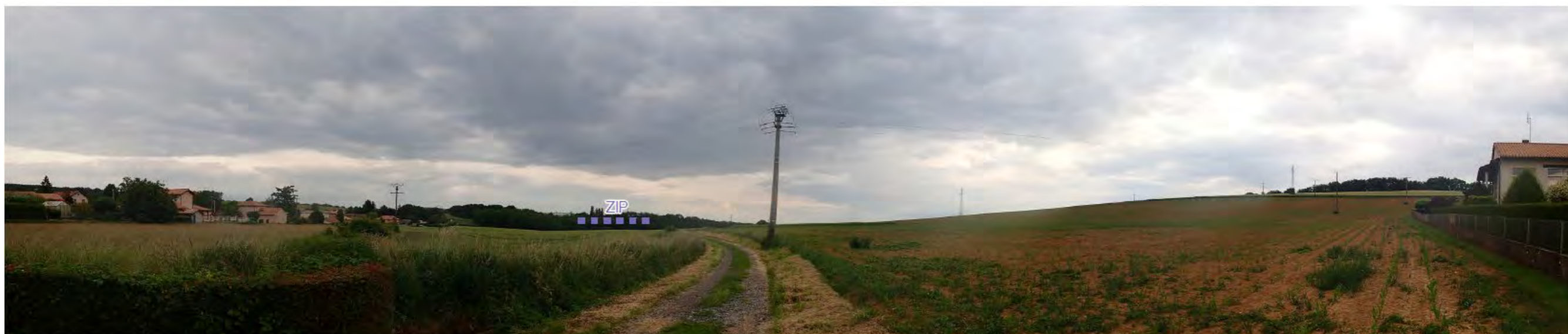
Photo 30 : Depuis la frange sud du hameau des Piasses, en fond de vallon, le relief et les boisements masquent le projet
