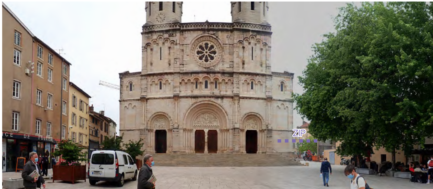
Photo 24 : Bien que la vue soit dégagée au premier plan, la trame bâtie masque le projet
