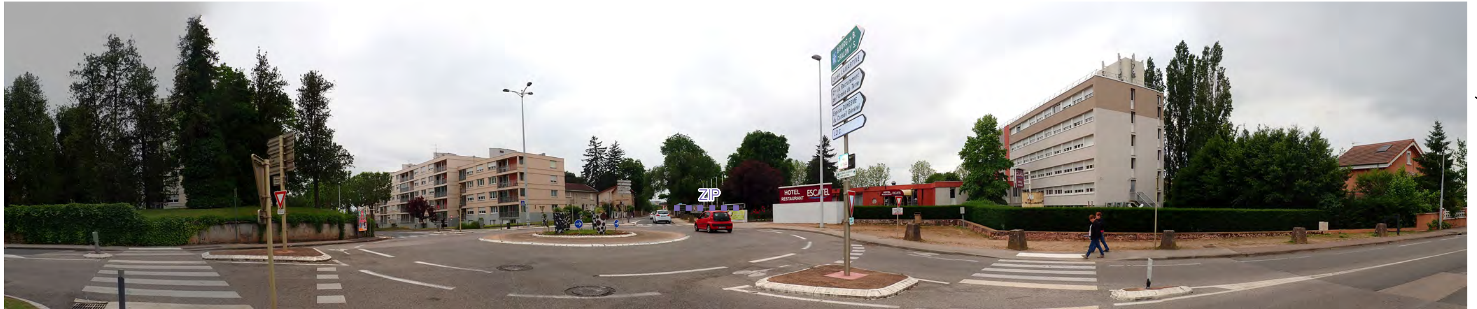
Photo 26 : La RD 82 rejoignant le centre-ville de Mâcon, la ZIP n'est pas perceptible ; masqué par la trame bâtie et le relief
