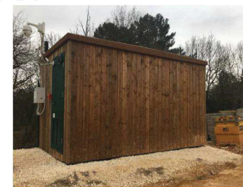
Figure 12 – Exemples de local technique avec bardage
