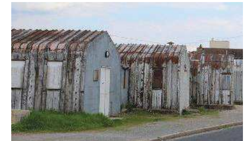
Pavillons Fillod ou préfabriqués de type "parois inclinées"
