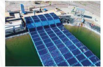
Les flotteurs sont assemblés par sous-ensemble sur la berge à proximité immédiate de la zone de mise à l'eau. Ce sous-ensemble est ensuite mis à l'eau et sera connecté au sous-ensemble suivant jusqu'à former un îlot. Celui-ci sera transporté par bateau jusqu'à son emplacement définitif pour y être ancré.
