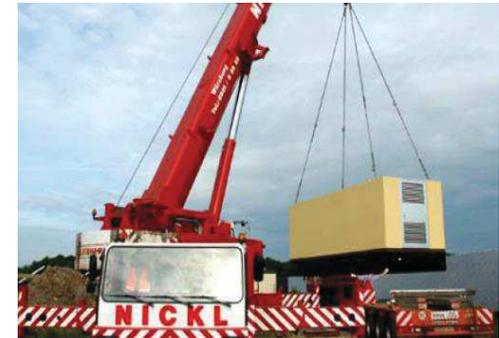
Exemple d'acheminement d'un poste technique préfabriqué
