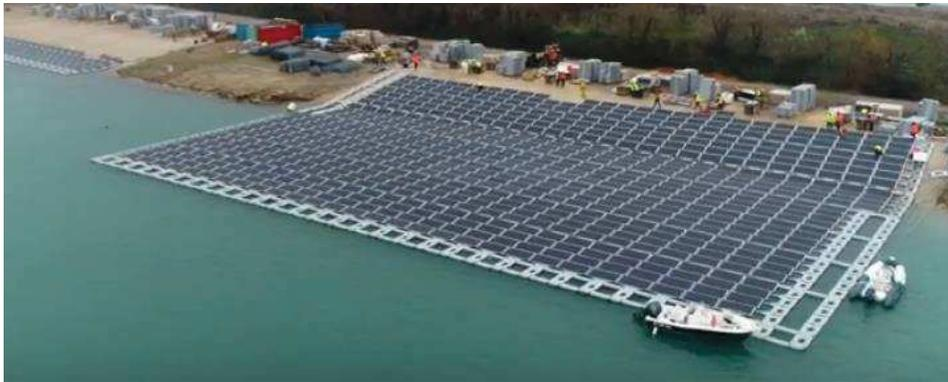
Montage des flotteurs et des panneaux sur la berge progressivement amenés sur le plan d'eau
