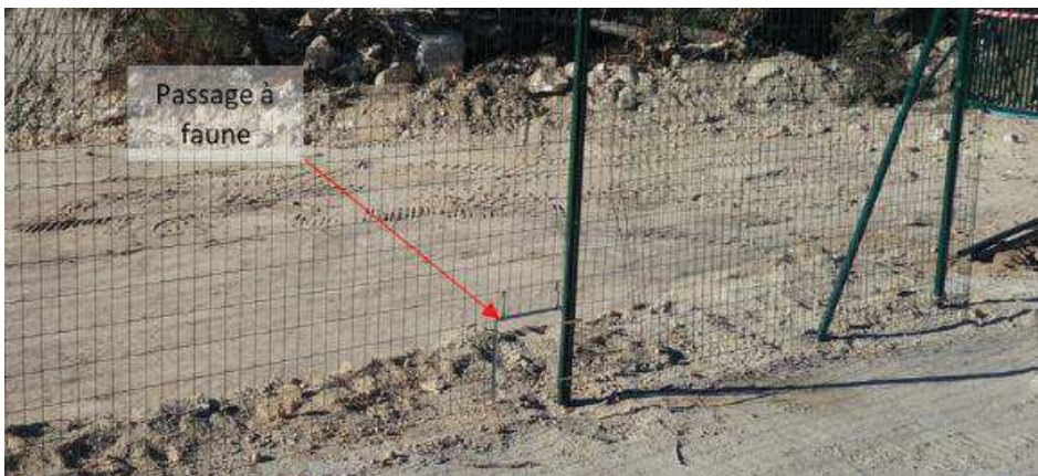
Exemple d'aménagement réalisé dans une clôture et permettant le passage de la petite faune.
