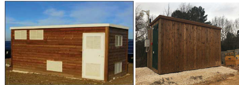
Exemples de locaux techniques avec bardage bois
