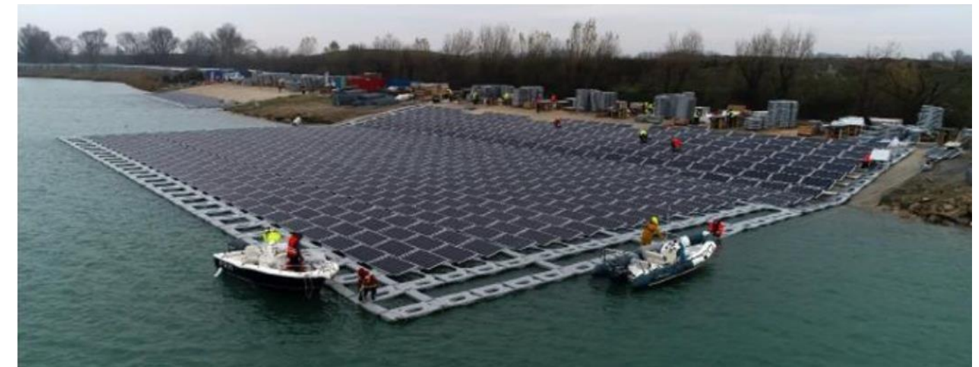
Phase de mise à l'eau des flotteurs (Plan d'eau de Piolenc - 84, Ciel-et-Terre)
