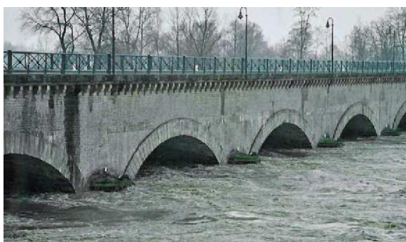
Pont canal de Digoin lors de la crue de novembre 2008
