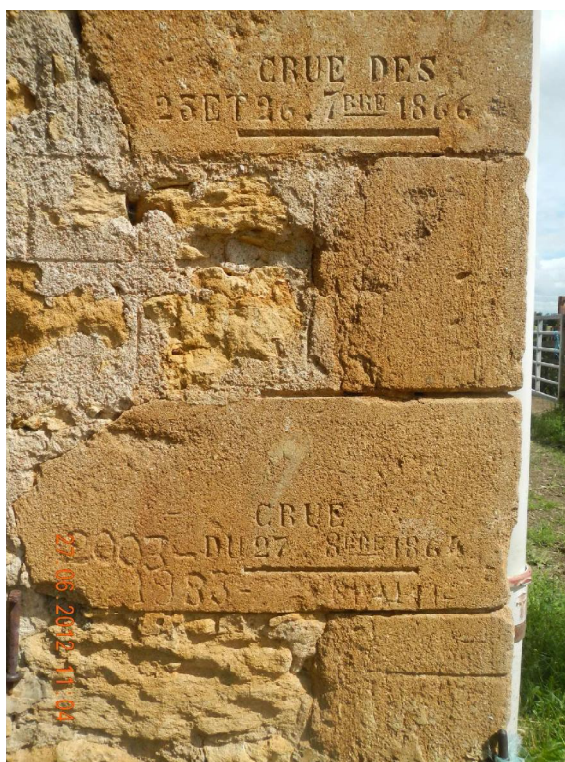
Figure 8 : Repères de crue de 2003 à Port Chasset
