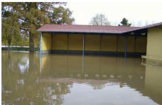
Marché couvert à Diou lors de la crue de novembre 2008
