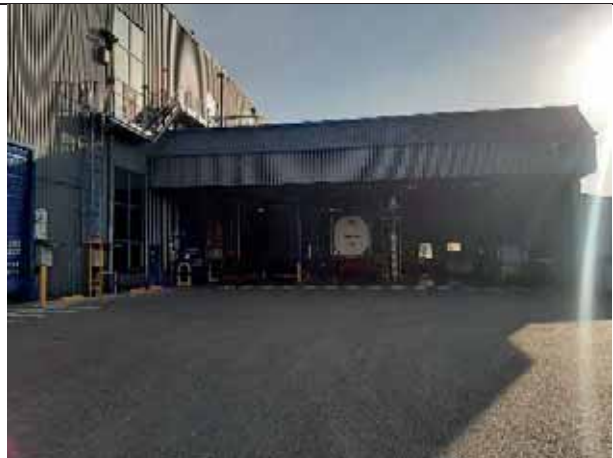
Bâtiment process- Auvent avec zone chargement/déchargement (n°14)
