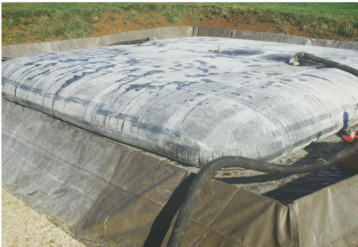
Figure 2 : Exemple de réservoir souple de 80 m<sup>3</sup>
