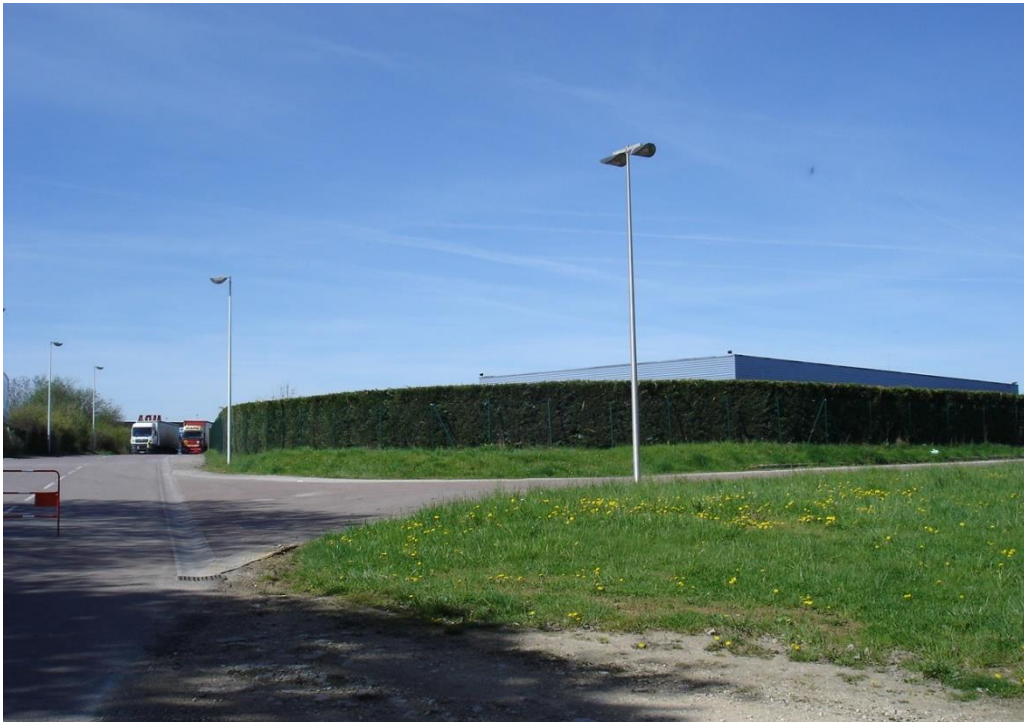
Figure 8 : Usine vue de l'est
