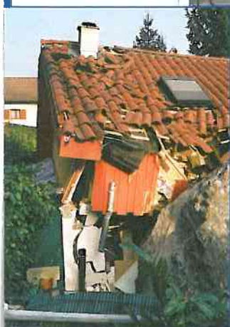
« Chute de blocs depuis le versant Est du massif de la Chartreuse Lumbin - janvier 2002 »
